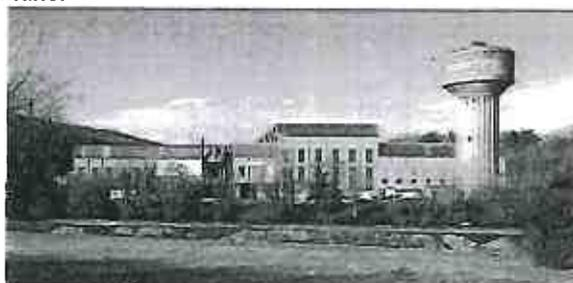
Ce bâtiment est composé de 6 nefs qui mesurent entre 120 et 168 mètres de long, sur une hauteur de 12 mètres et sont équipées de ponts roulants encore exploitables aujourd'hui. La couverture du bâtiment était initialement constituée de sheds en bacs acier et verre.
