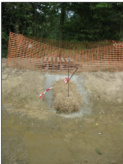
Photo 1 : Emplacement du filtre à particules fines (botte de paille) pendant la phase des travaux au niveau du bassin d'orage
