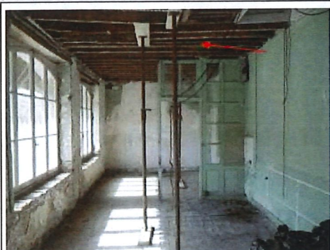
N°1 – ETAIS SOUS PLANCHER HAUT ETAGE
