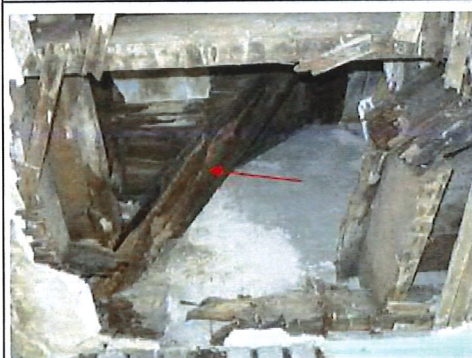
N°1 – ETAIS SOUS PLANCHER HAUT ETAGE
