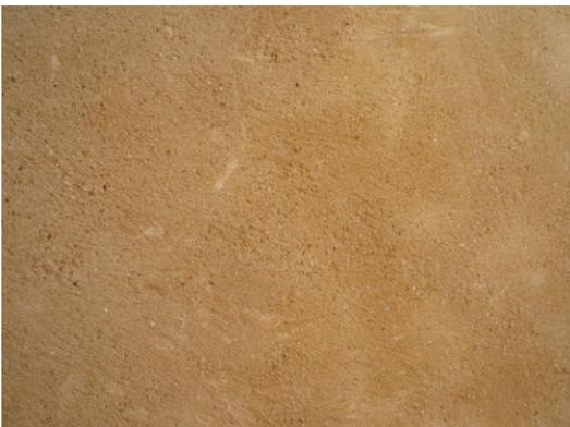
exemple d'enduit de finition à la chaux
