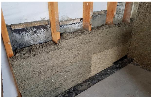
exemple de mise en œuvre d'isolation par l'intérieur, bâtiment passif
