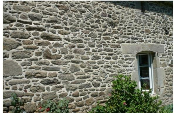
exemple de joints extérieurs chaux/sable
